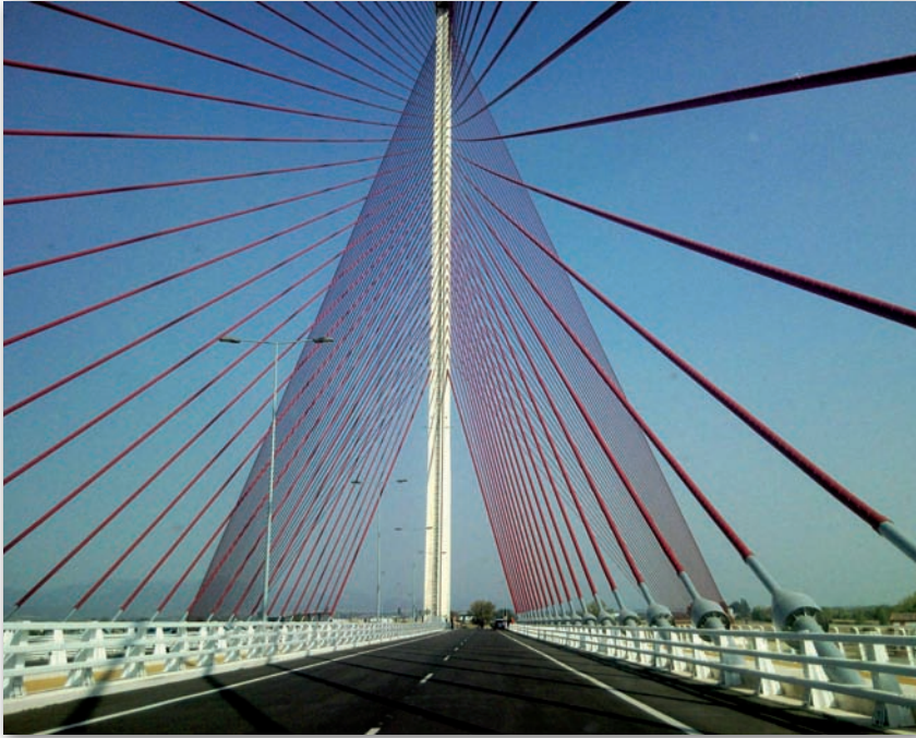
Puente de Castilla-La Mancha en Talavera de la Reina, ejemplo ilustrativo de cómo funcionan los hilos tensores
